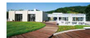
屋上緑化施設
