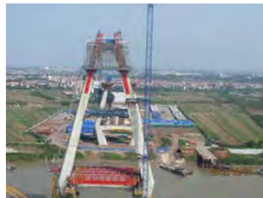
ニャッタン橋の構造を現地で学習
