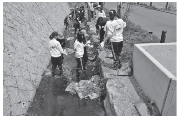
コンクリート側溝への土のう積み
